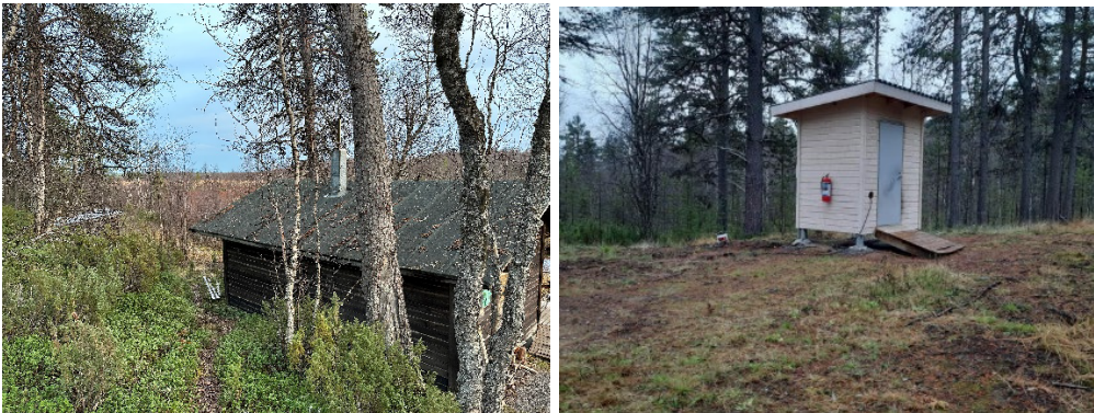
Kuva 7 Saunarakennus ja sen vieressä oleva halkoliiteri sekä lähistöllä oleva uusi agrekaattikoppi
