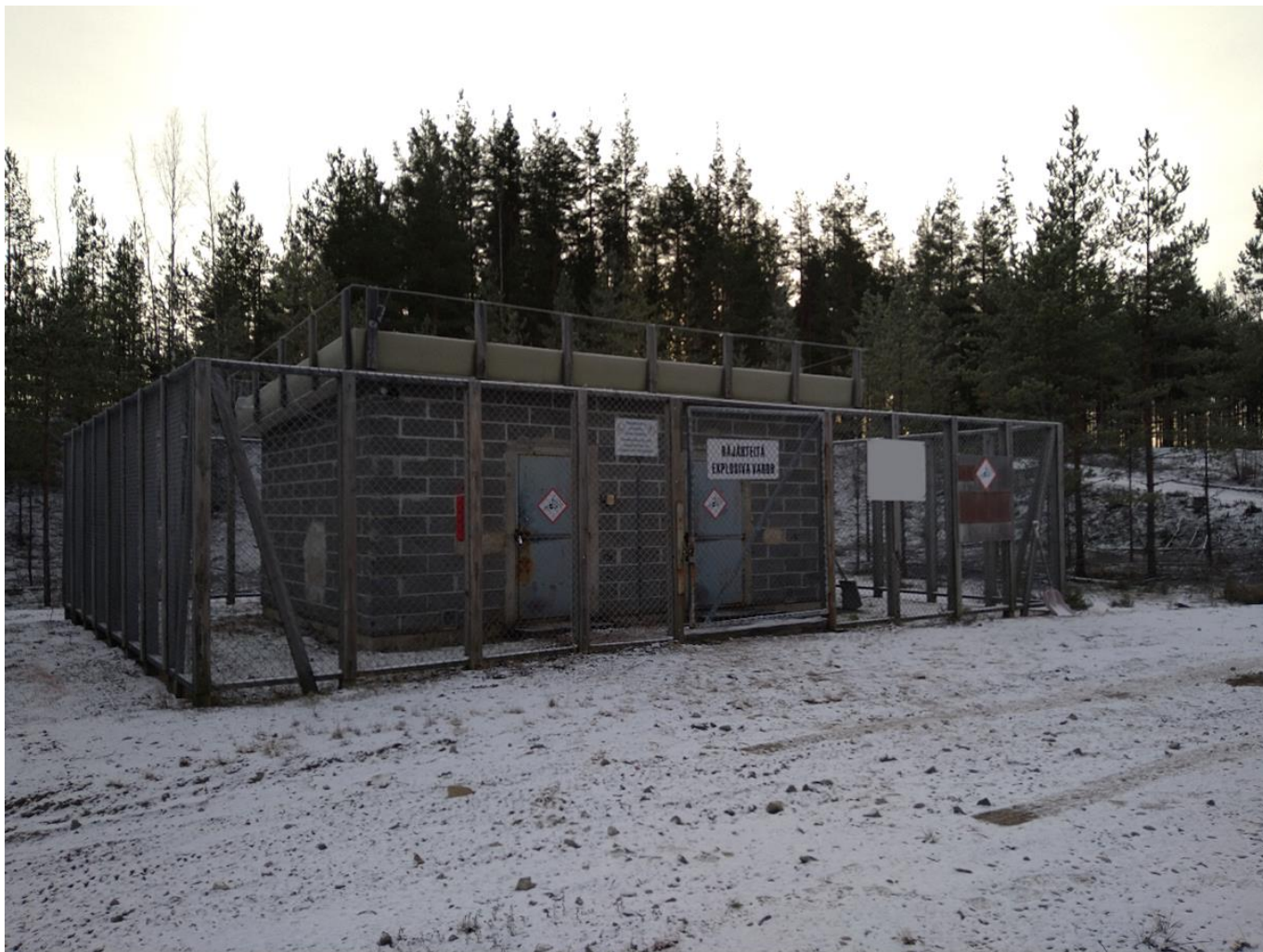
Kuva 1. Esimerkkikuva räjähddevaraston varoitusmerkinnöistä.
